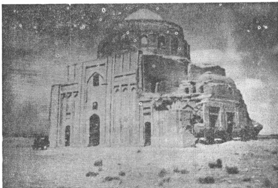
ضلع شمالی و شرقی خانقاه هارونیه پیش از مرمت
