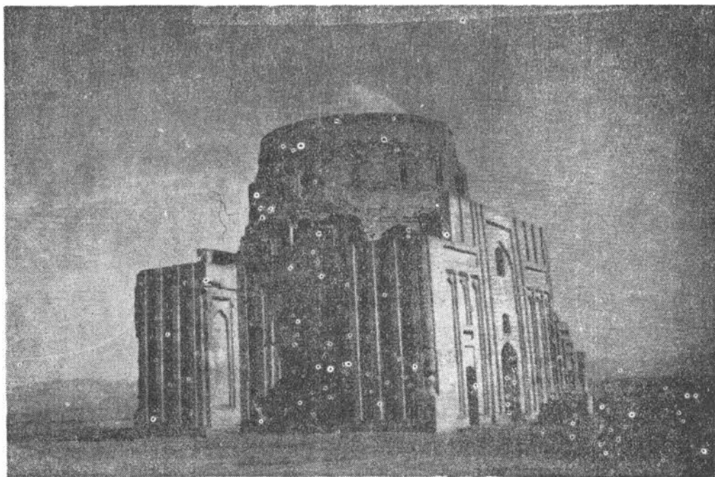
ضلع جنوب شرقی خانقاه هارونیه پیش از مرمت
